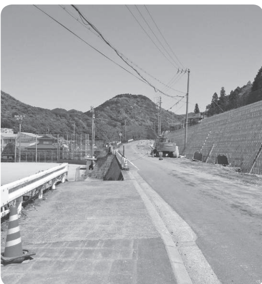
工事中の町道大又岡本線
