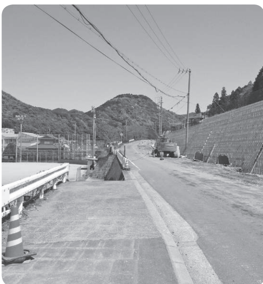
工事中の町道大又岡本線
