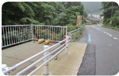
国道424号の歩道整備
