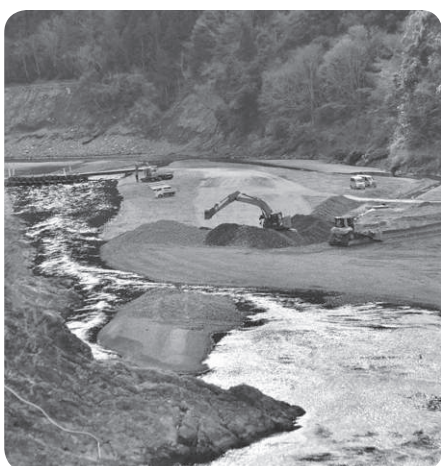
土砂撤去工事
