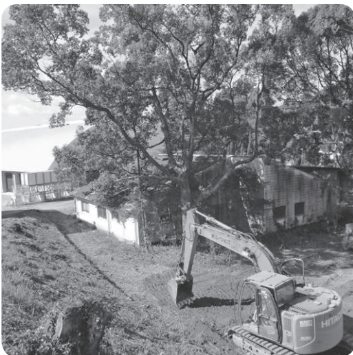
かわべテニス公園整備現場
