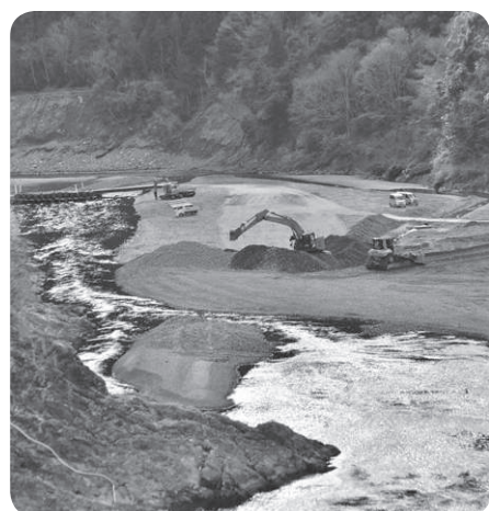
土砂撤去工事
