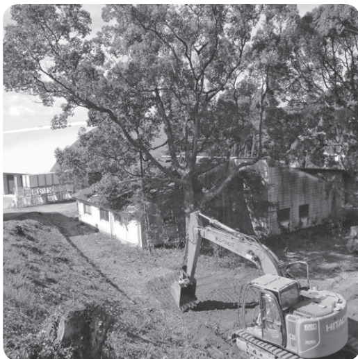
かわベテニス公園整備現場
