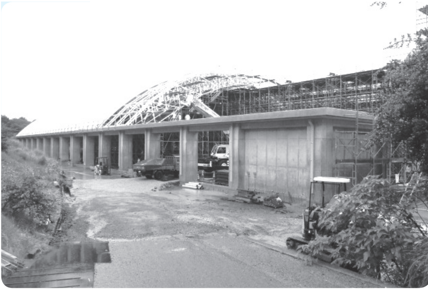
テニスコート上屋整備工事
