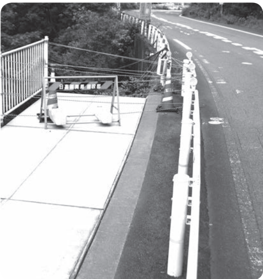
国道への歩道設置工事
