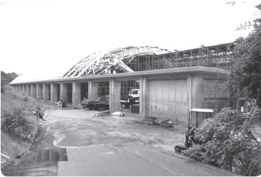
テニスコート上屋整備工事
