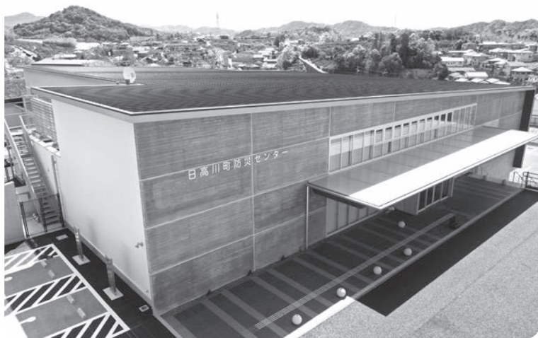
日高川町防災センター(正面玄関付近)
