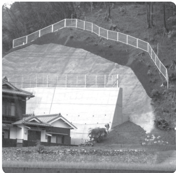
急傾斜対策工事
