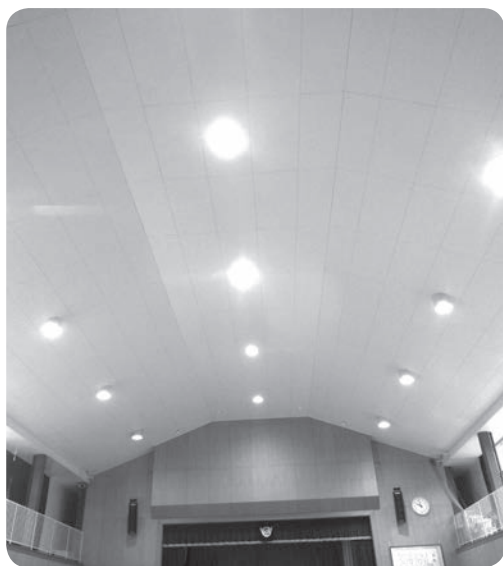
川辺西小 体育館天井
