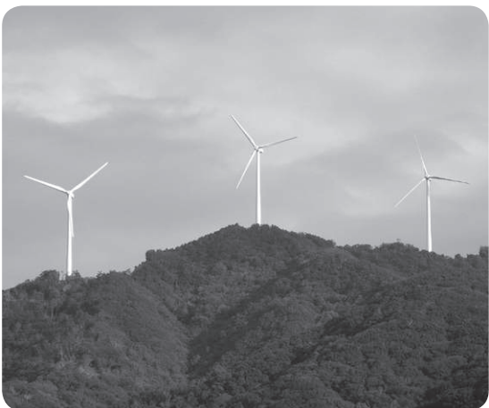
白馬林道沿いの風力発電施設
