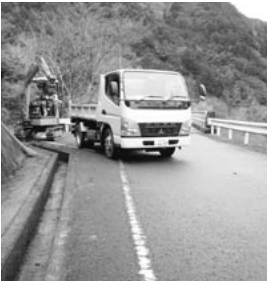
道路整備作業
