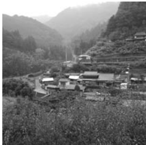
水道未整備地区(寒川)
