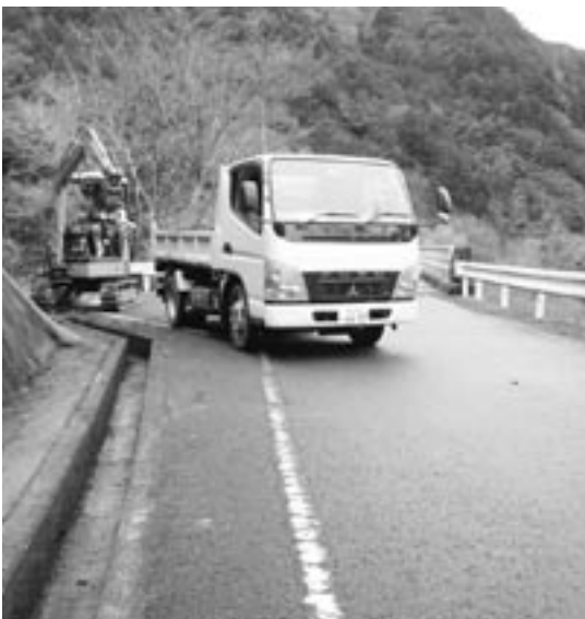
道路整備作業
