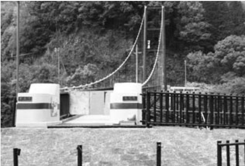
鳴滝橋（町道中木佐井線）
