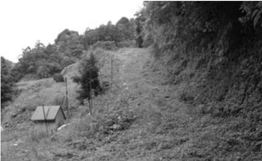
小規模土地改良事業で舗装する藤野川のしらかせ農道
