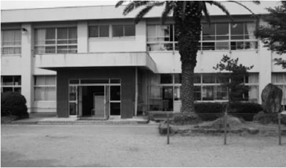
耐震補強される川辺西小学校
