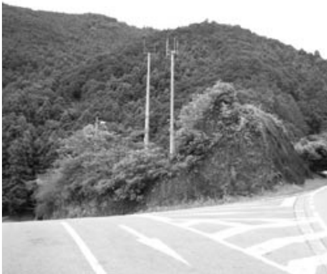
携帯電話の通信塔
