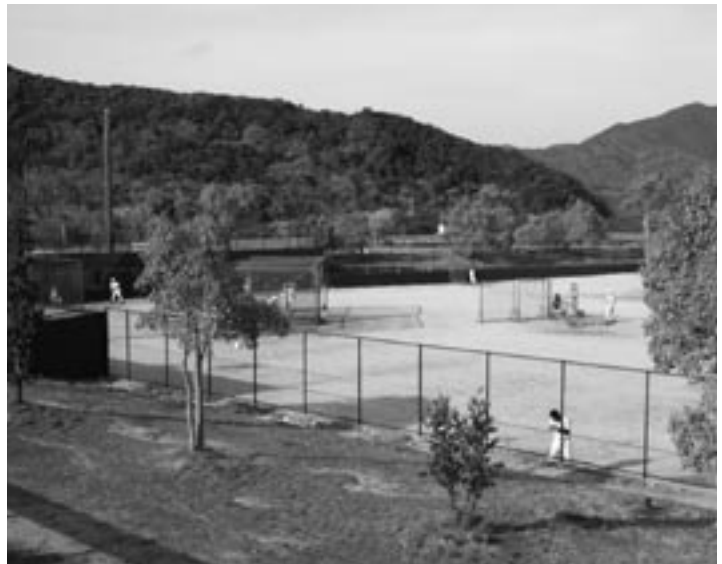
照明設備を設置する南山野球場
