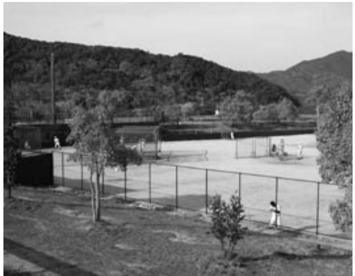
照明設備を設置する南山野球場
