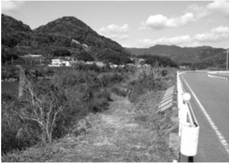
舗装される和佐の消防道路
