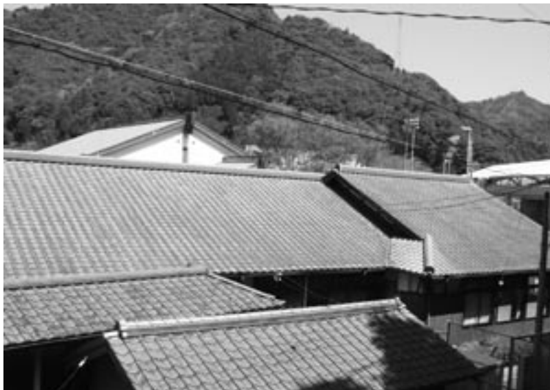
改修予定の愛徳荘の屋根
