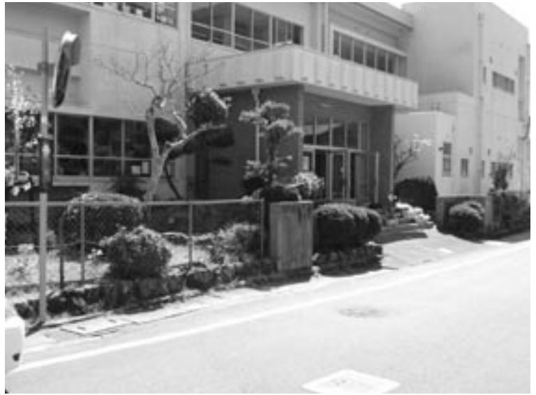
耐震補強される三百瀬小学校
