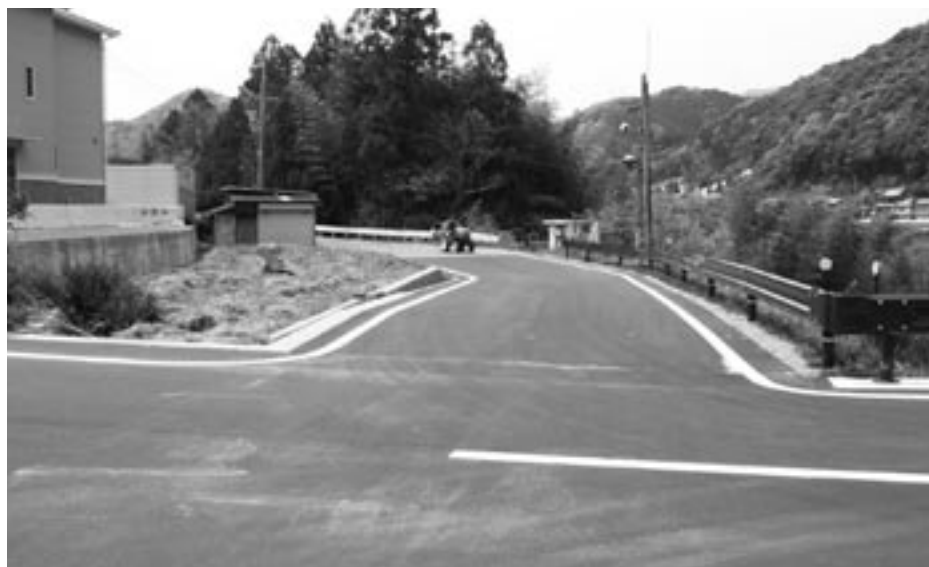
認定された町道観音寺橋線
