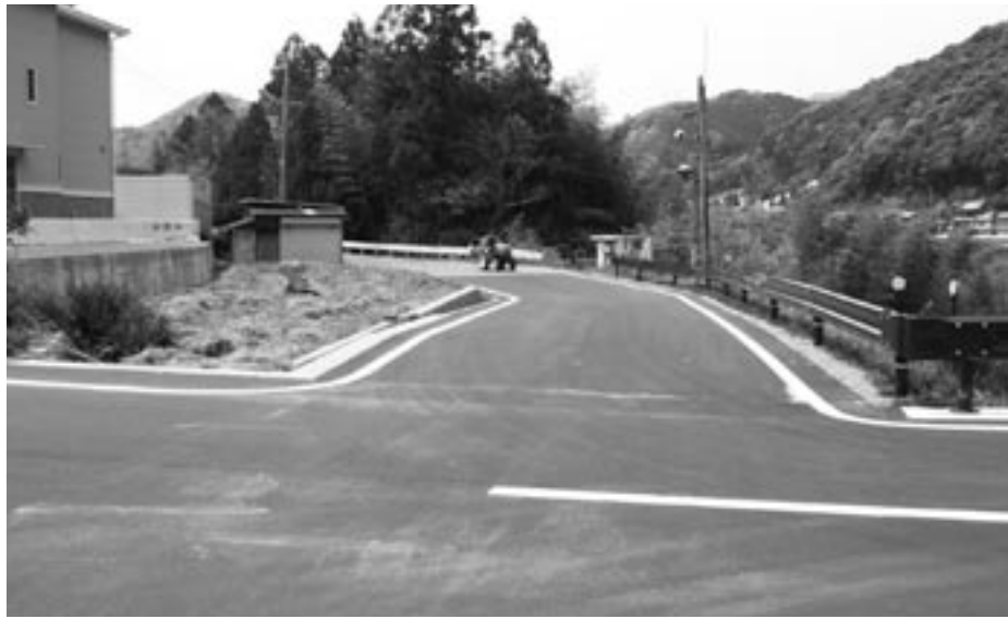
認定された町道観音寺橋線
