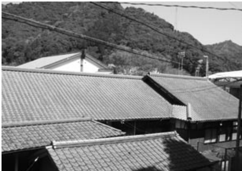
改修予定の愛徳荘の屋根
