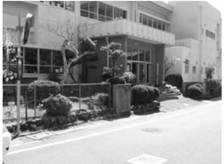
耐震補強される三百瀬小学校
