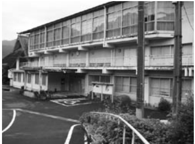
解体される旧中津公民館(上)と旧中津川小体育館(下)
