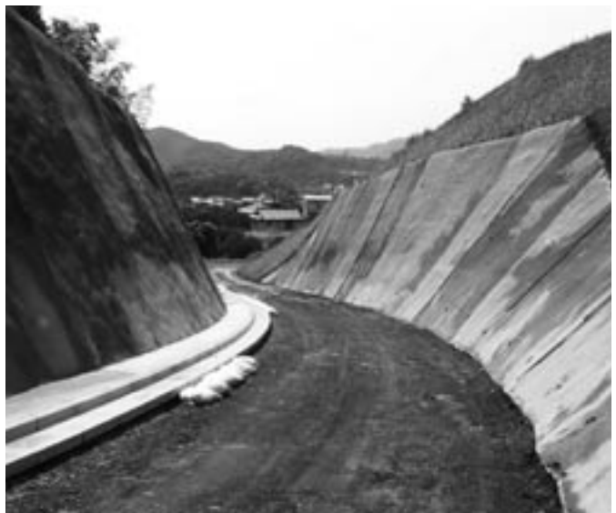
改良工事中の下入野農道
