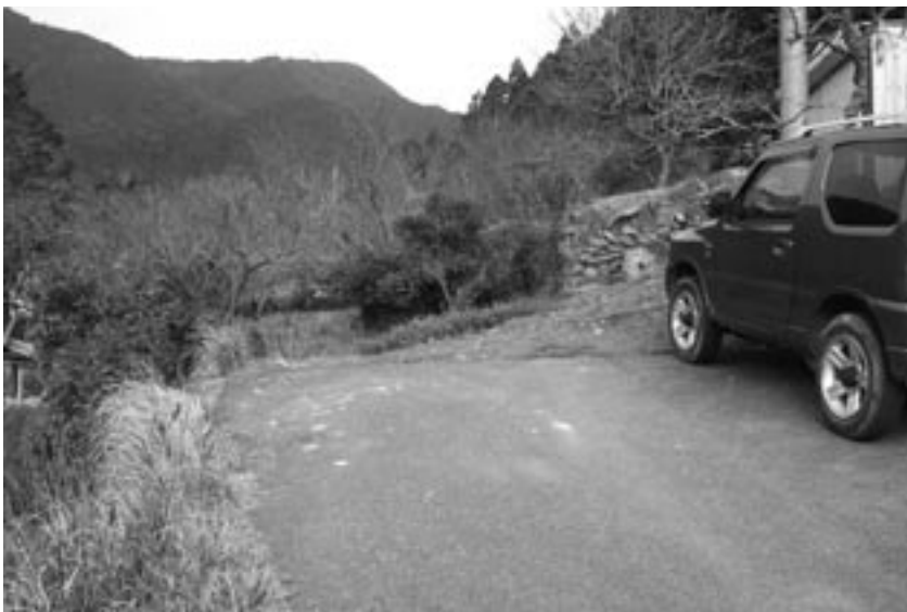
改良が着手される集落道川原河線
