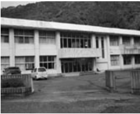
太陽光発電を設置する笠松小学校
