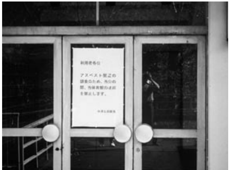
使用禁止となった中津公民館
