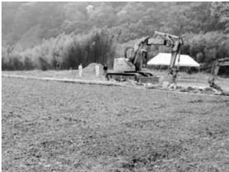
早蘇簡易水道施設工事
