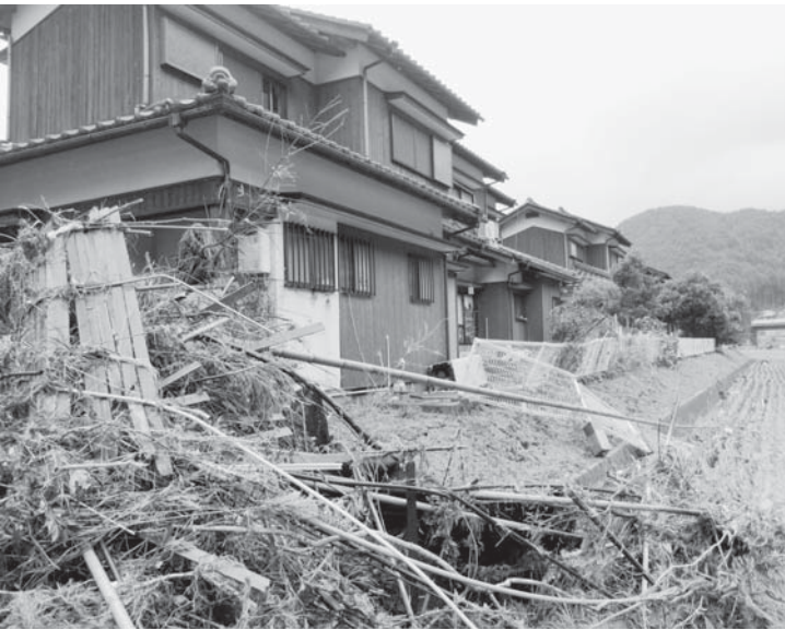
被災した町営住宅
