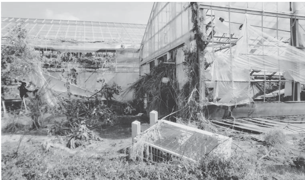
被災した農業ハウス
