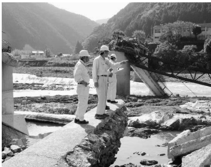
流失した皆瀬橋付近
