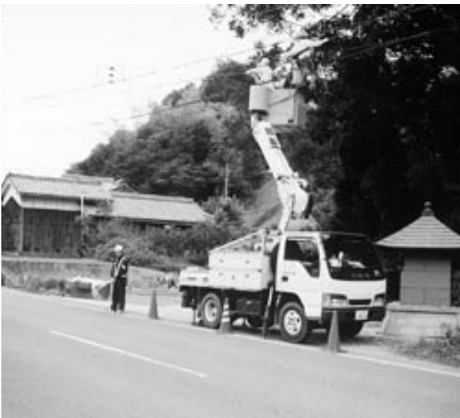
すすむケーブルテレビ工事
