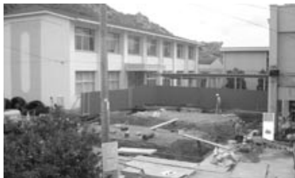
丹生中学校給食調理棟基礎工事
