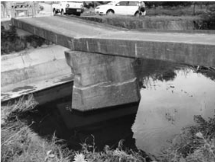
土生地内 鍛冶屋橋
