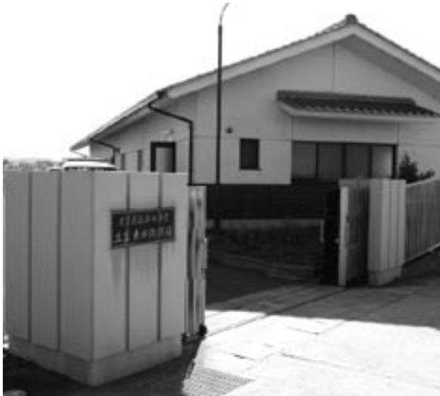
土生・矢田地区 集落排水処理場
