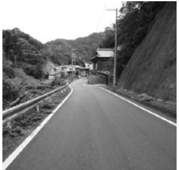
県道御坊中津線三津ノ川地内
