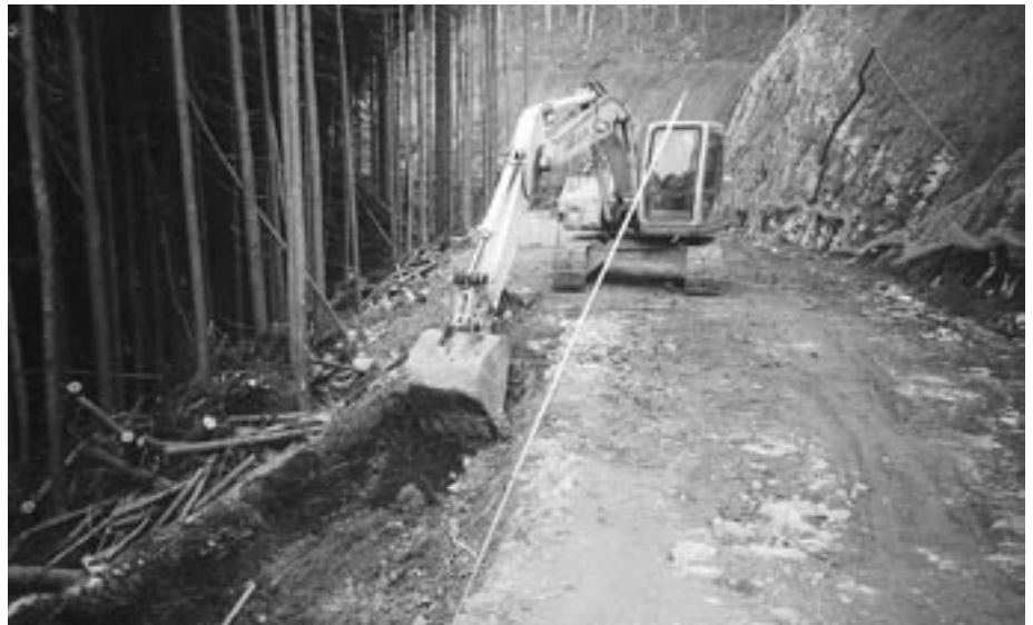
林道株井白馬線開設工事
