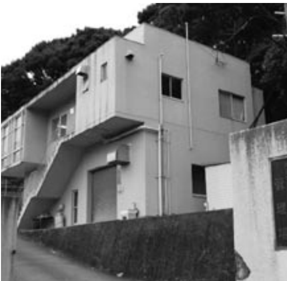
川辺簡易水道入野管理棟
