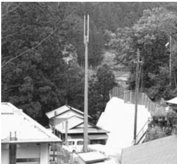
移動通信用鉄塔（寒川地内）
