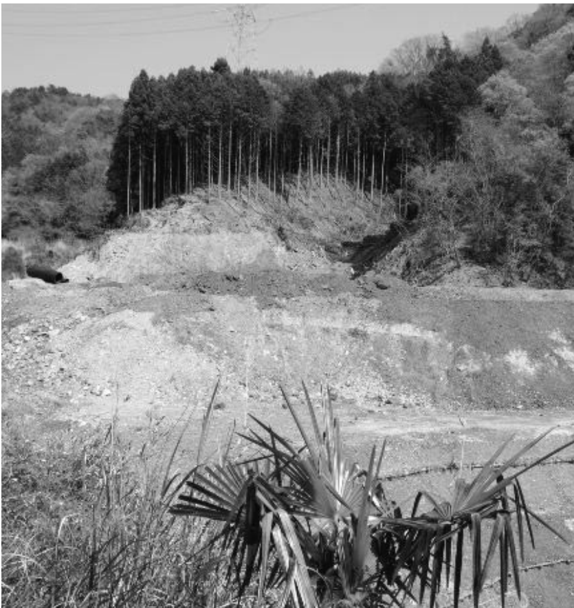
株井残土処理場
