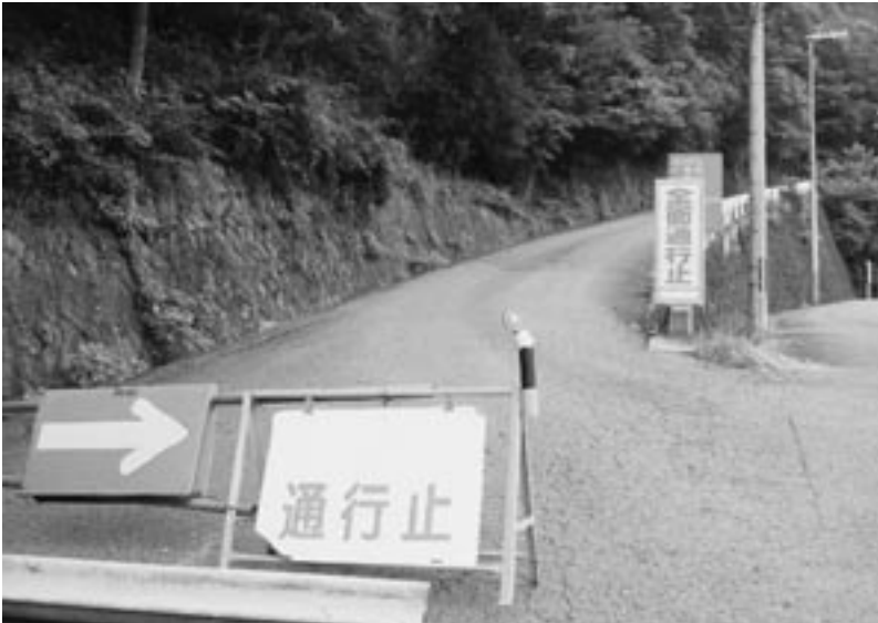
全面通行止 美山打尾地内
