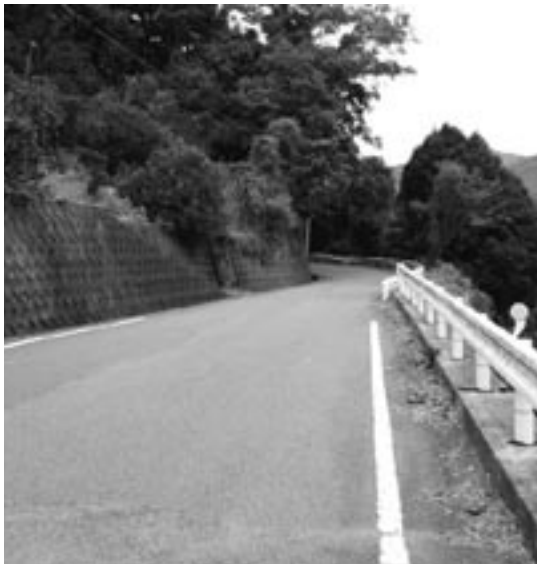
県道玄子小松原線（中津川地内）
