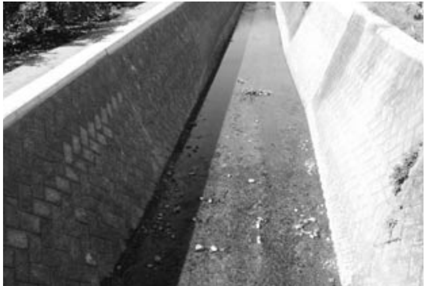
自然環境に配慮した河川工事（玄子地内）
