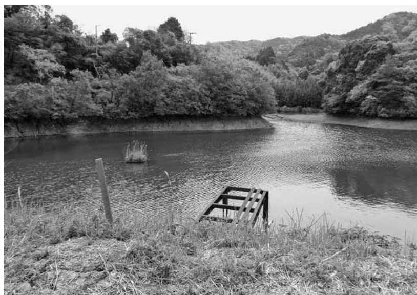
耐震調査されるため池
