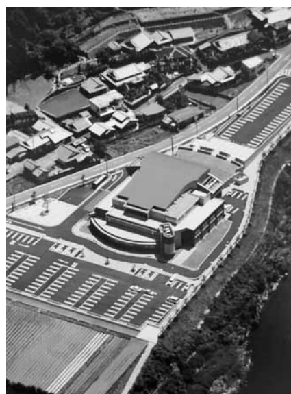
太陽光発電設置(交流センター)
