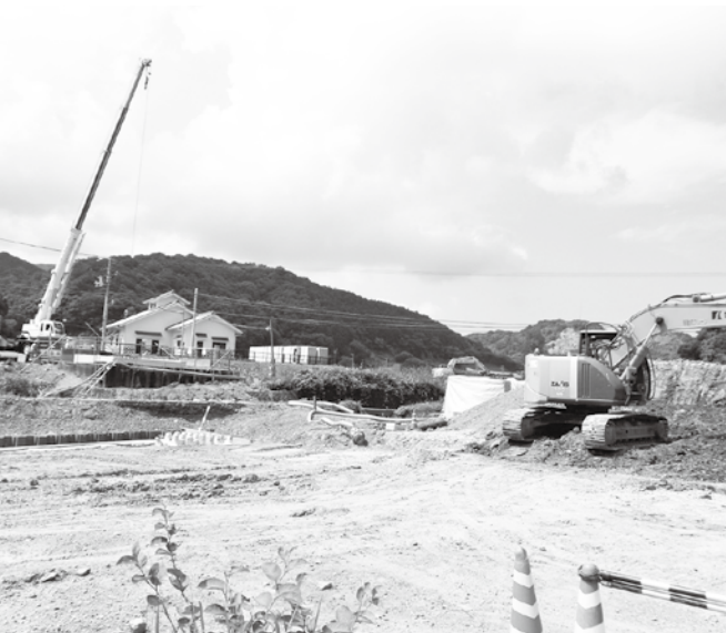
越内橋橋梁災害改良工事
