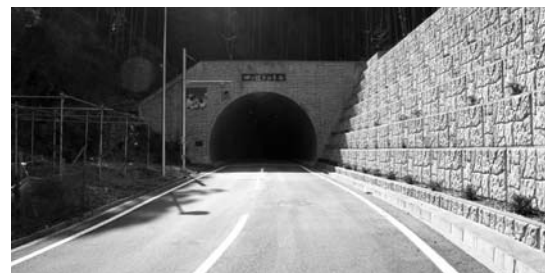
▲四ツ辻トンネル
