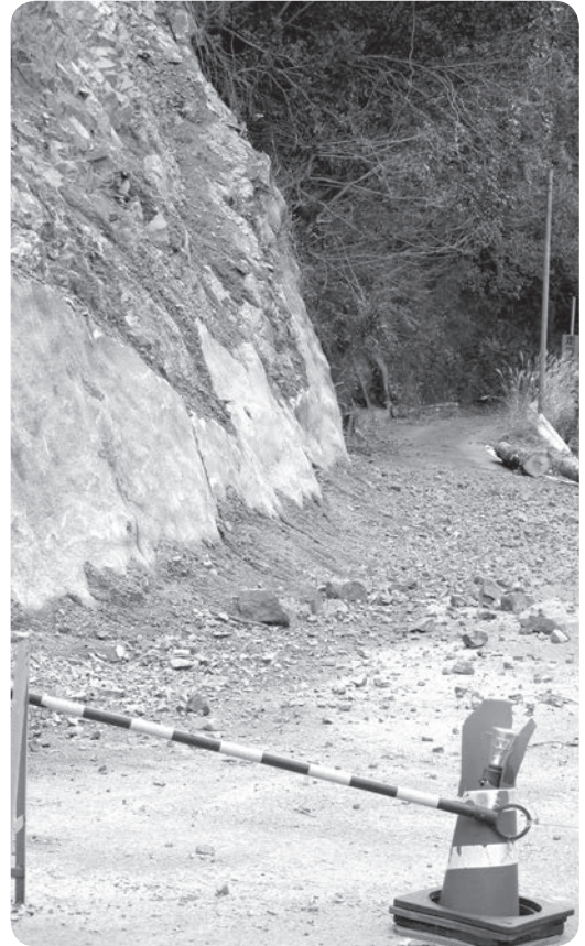
心配される、山崩れによる孤立化
