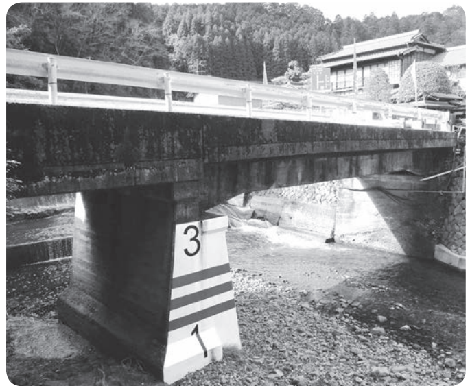
寒川地内の明神橋
