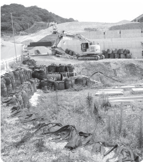
インターチェンジの工事現場
