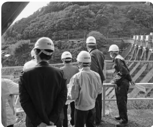
椿山ダム側壁倒壊復旧工事
