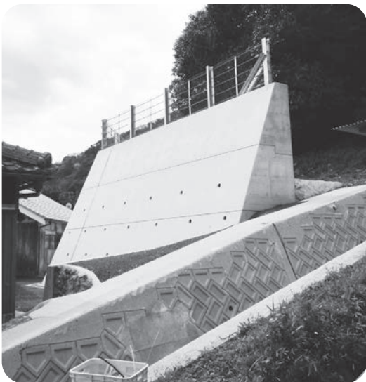
急傾斜地崩壊対策
