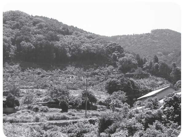
メガソーラー建設予定地（写真は坂本地内）
