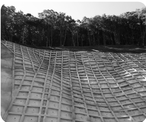
法枠工（町道小滝浦線）
