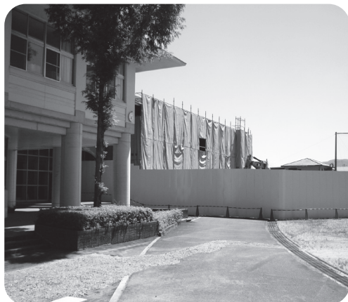
工事中の早蘇中学校
