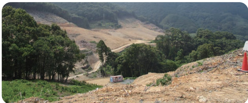
太陽光発電建設現場（船津地内）
