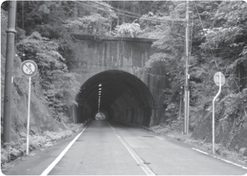
御坊美山線株井トンネル
