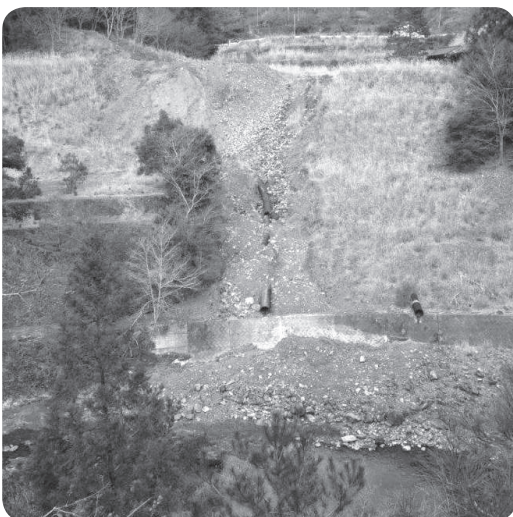
寒川地内の盛土
