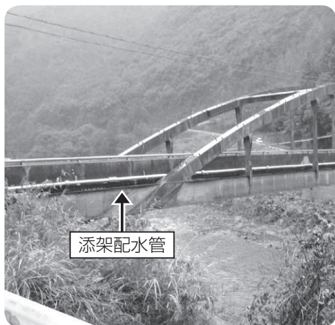
道路橋に添架された配水管
