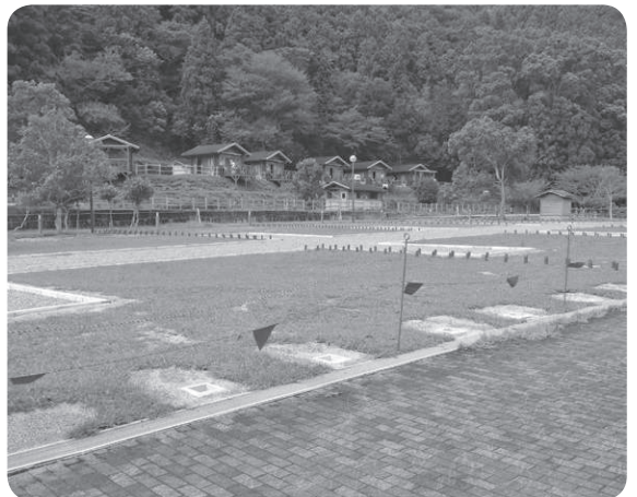
整備中のオートキャンプ場(高津尾地内)
