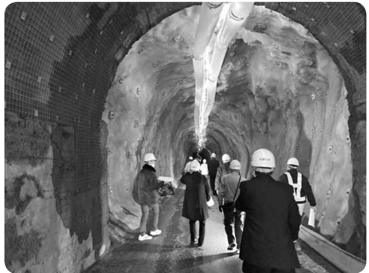
法事トンネル内
