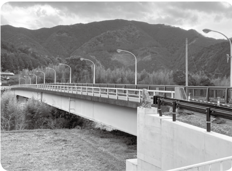
新田橋(高津尾地内)
